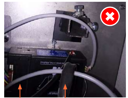
led-modulekabel ontsteekkabel
