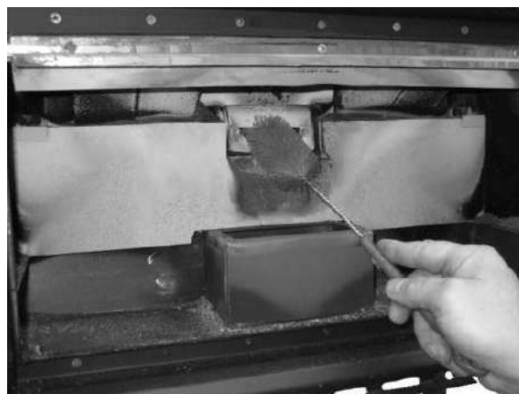
Fig. 34 - Reiniging met flessenwisser
