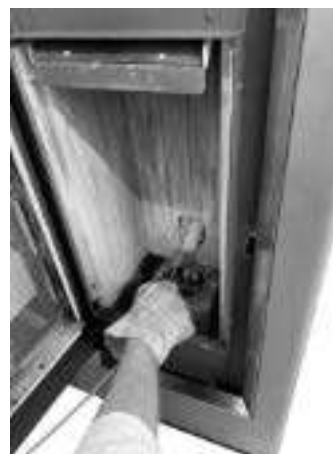
Fig. 36 - Reiniging met flessenwisser
