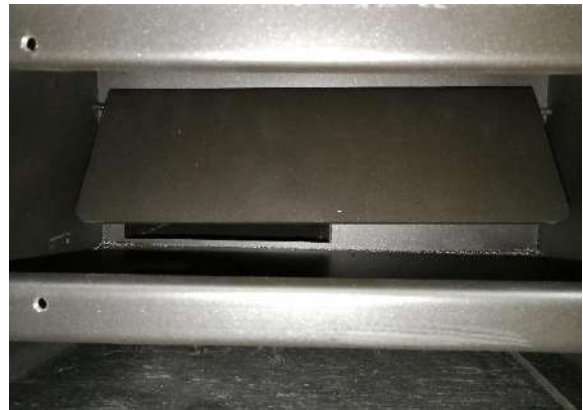
Bild 2: Überprüfen Sie die korrekte Position der Rauchleitplatte.
