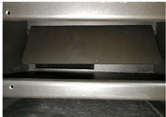
Bild 2: Überprüfen Sie die korrekte Position der Rauchleitplatte.
