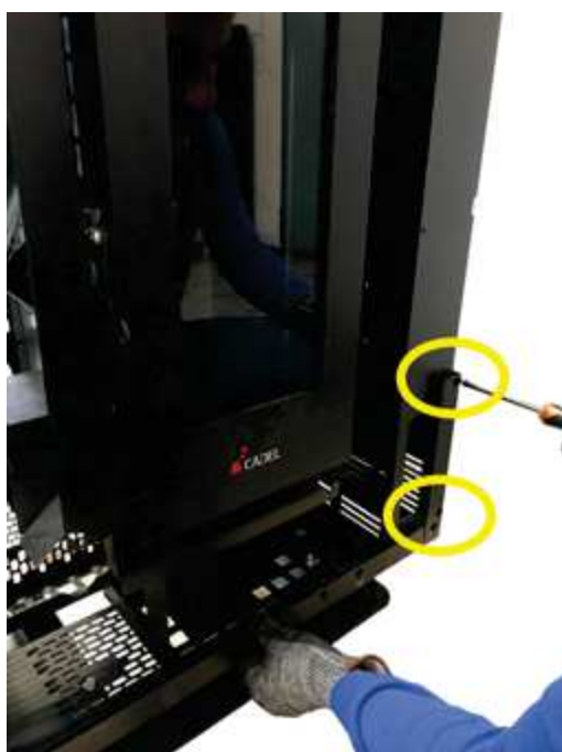
Fig. 34 - Bevestiging onderste beugel
