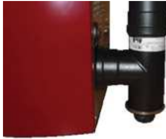
Fig. 87 - Reiniging rookleiding
