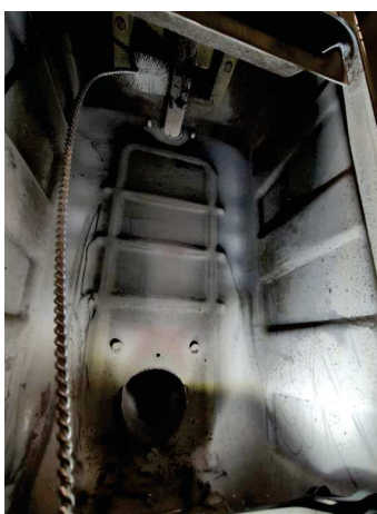
Fig. 81 - Reinig met pijpenwisser
