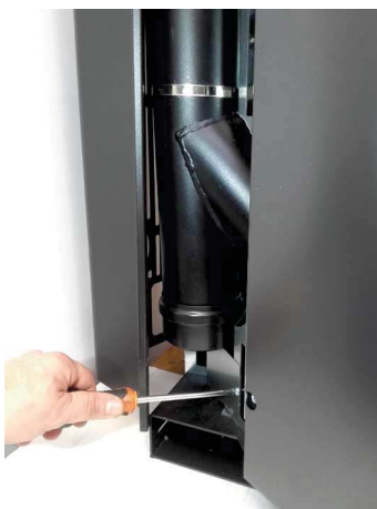
Fig. 75 - Schroef de dopblokkering los
